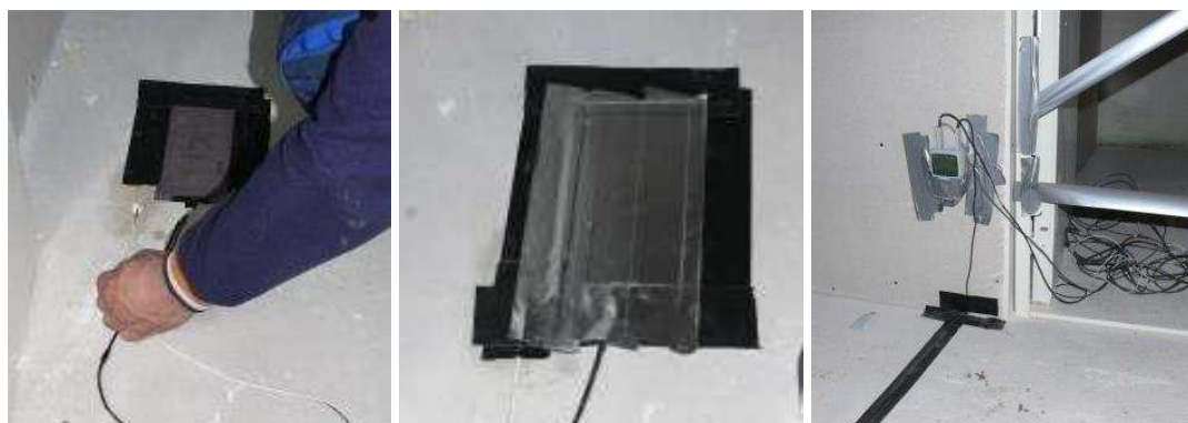
Figura 6 – Medidor de flujo de calor y sensor de temperatura superficial puestos sobre el forjado bajo cubierta, en el espacio de trasteros.
