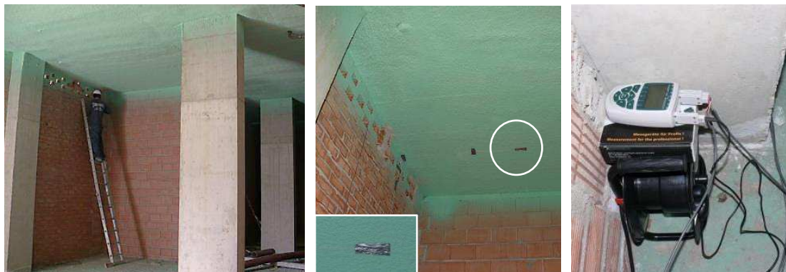
Figura 5 – Puesta en sitio del sensor de temperatura exterior para el forjado de la planta primera sobre portales.
