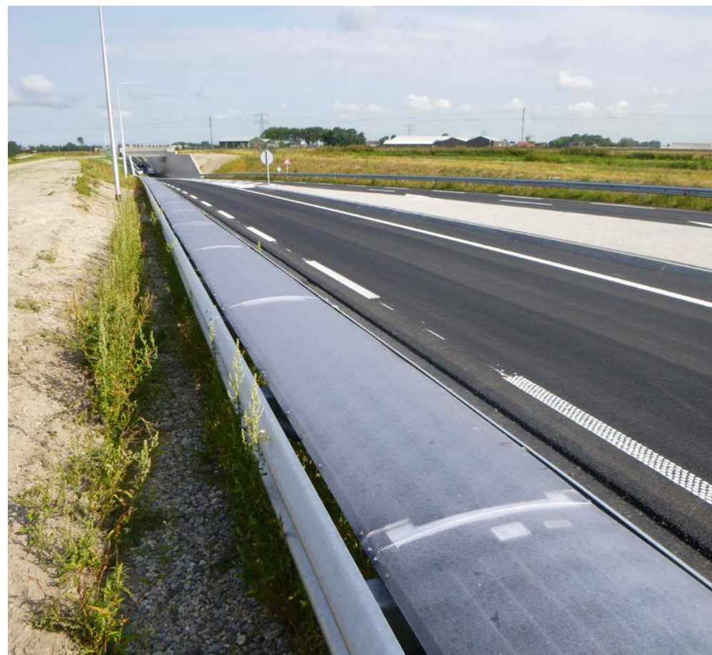
Intégration PV dans une double glissière de sécurité de 72 m de long le long de la N194 près de Heerhugowaard, aux Pays-Bas. ©Solliance | solliance.eu
