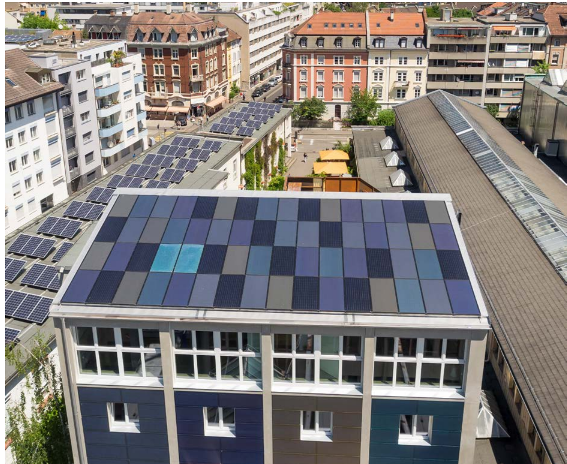
Système photovoltaïque intégré au bâtiment. ©Argola Solvatec
