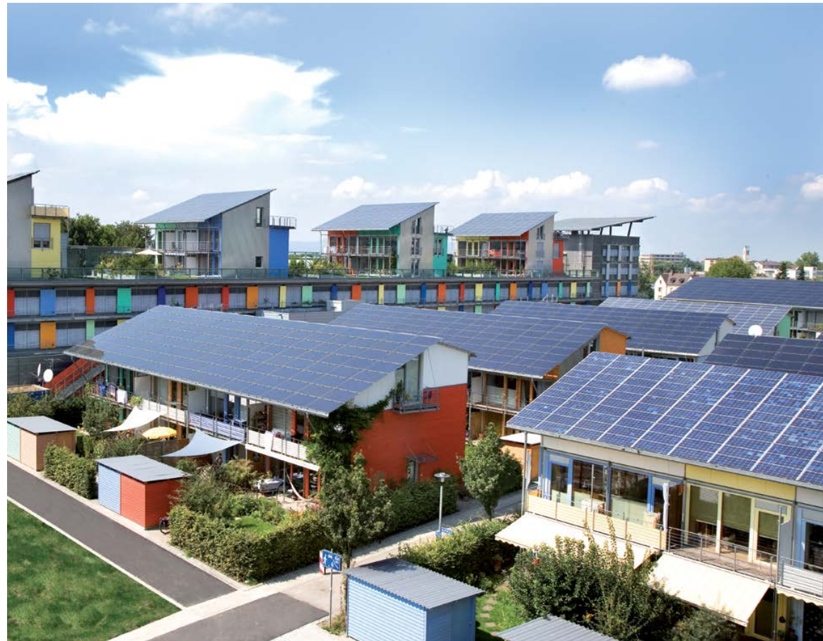
Village solaire à Fribourg, Allemagne. ©Rolf Disch Architecture solaire | rolfdisch.de
