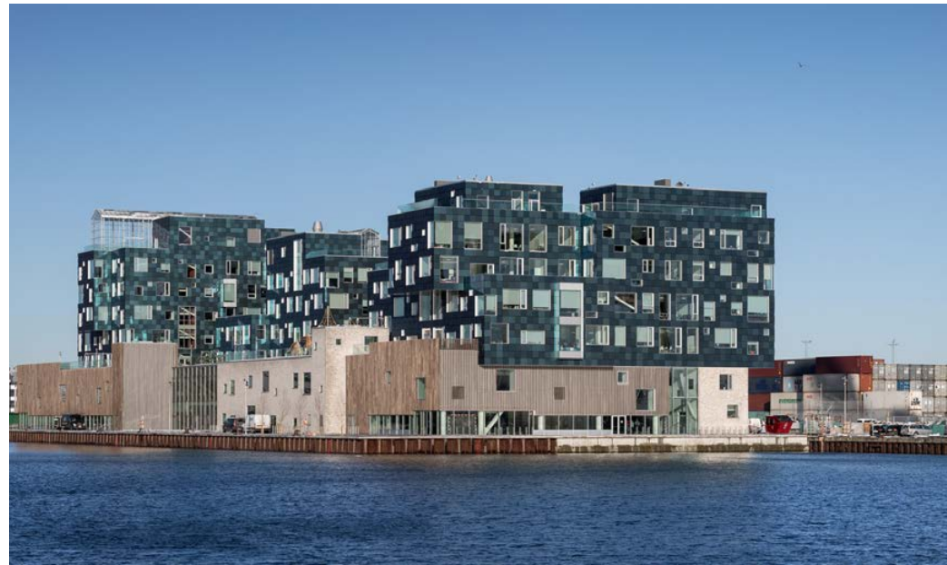
©Adam Mørk. Bâtiment de l'école internationale de Copenhague avec 12 000 panneaux BIPV colorés de forme carrée.
