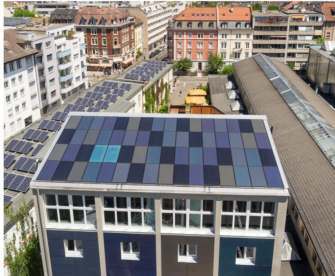
Gebäudeintegrierte Photovoltaik. © [Argola Solvatec](http://argola-solvatec.com)
