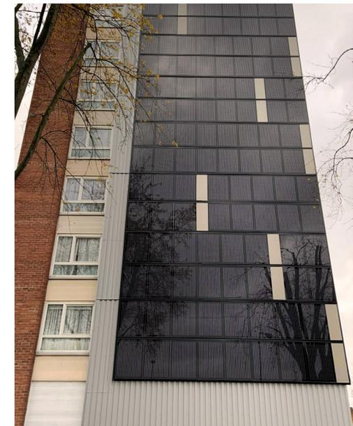
BIPV-belüftete Fassade eines Mehrfamilienhauses, Wattignies, Frankreich. ©Onyx | onyx-solar.com Demonstrationsprojekt für PV-Standorte.
