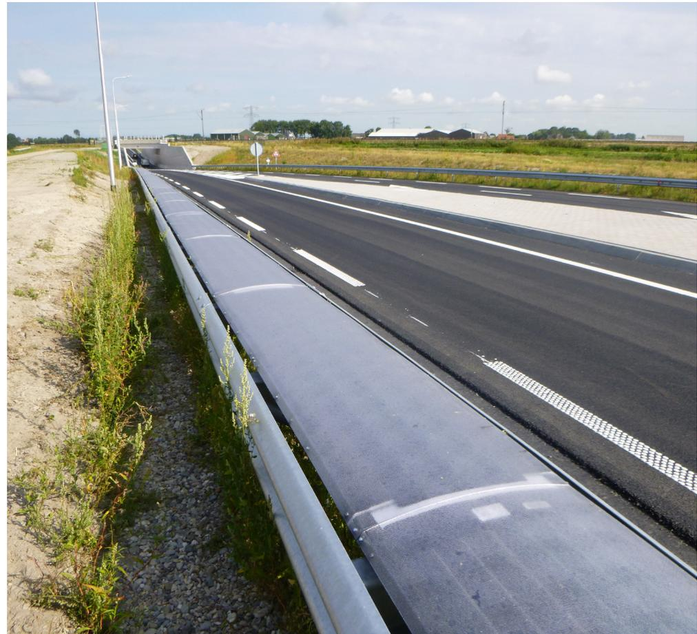
PV-Integration in 72 m lange Doppelleitplanke entlang der N194 bei Heerhugowaard, Niederlande.
