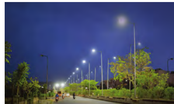
À Jaipur, en Inde, des lampadaires intelligents dotés de capteurs de mouvement et de contrôleurs sans fil ajustent la luminosité en temps réel en fonction de la présence humaine, améliorant ainsi les services municipaux et la sécurité. © tvilight.com
