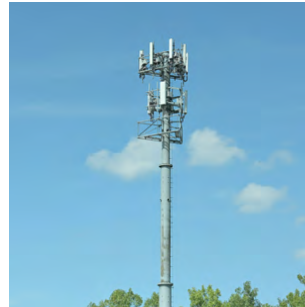
Pylône de télécommunication ©Nathan Anderson, Unsplash
