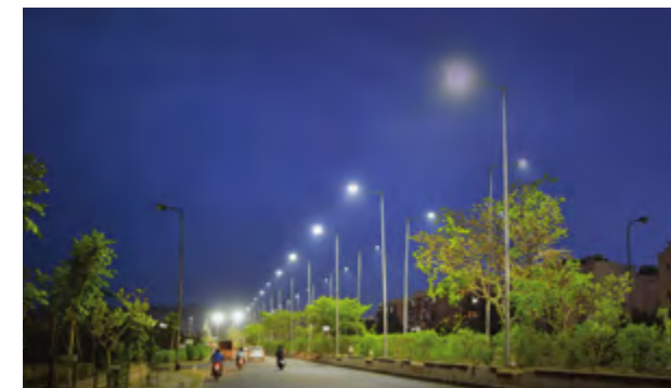
In Jaipur, Indien, passen intelligente Straßenlaternen mit Bewegungssensoren und drahtlosen Controllern die Helligkeit in Echtzeit an die Anwesenheit von Menschen an und verbessern so die städtischen Dienstleistungen und die Sicherheit.
