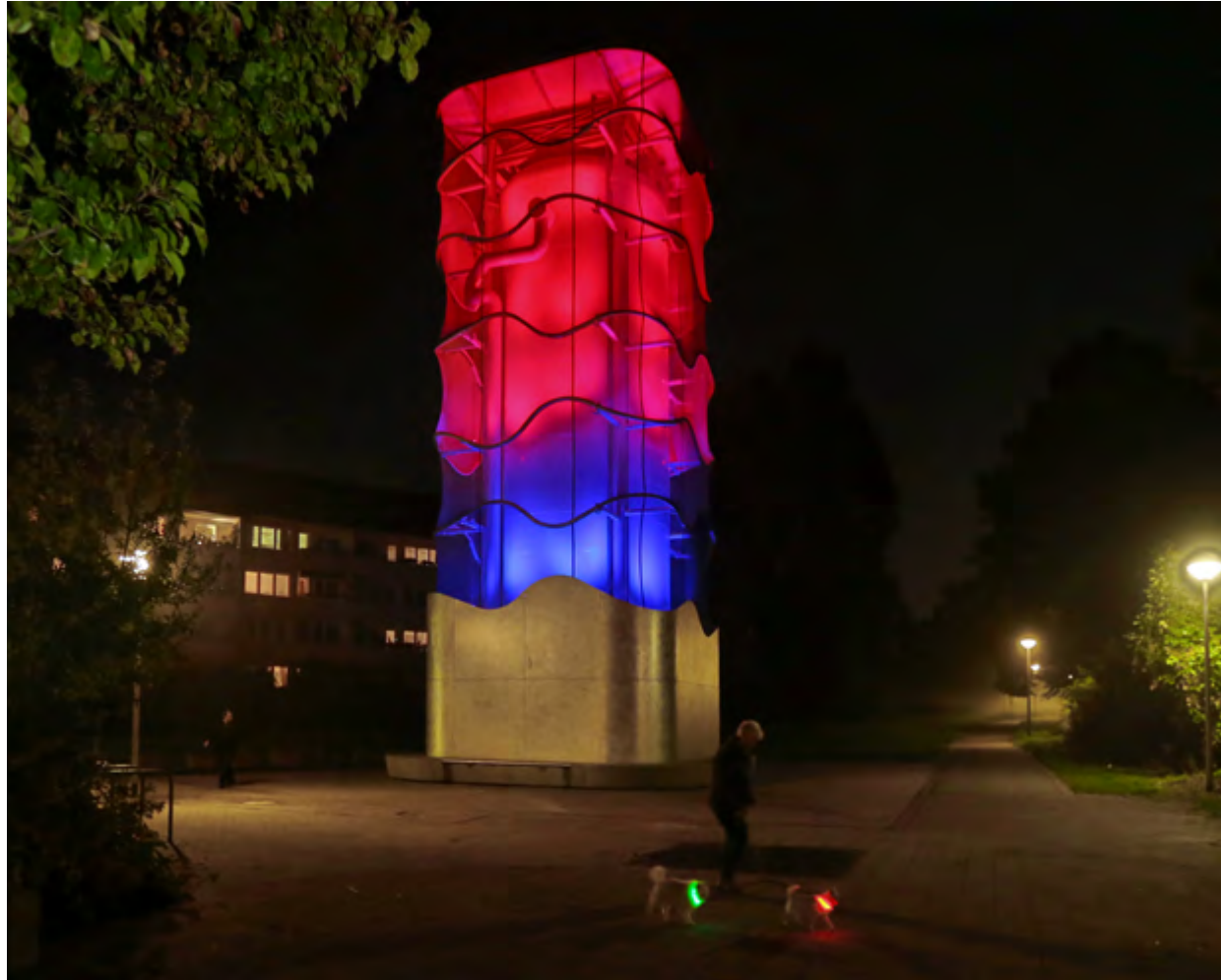
Intégration architecturale d'un réservoir de stockage d'eau de chauffage urbain à Hildesheim. La couleur de l'éclairage passe du rouge au bleu en fonction de la quantité d'énergie stockée dans le réservoir. ©Lighting design
