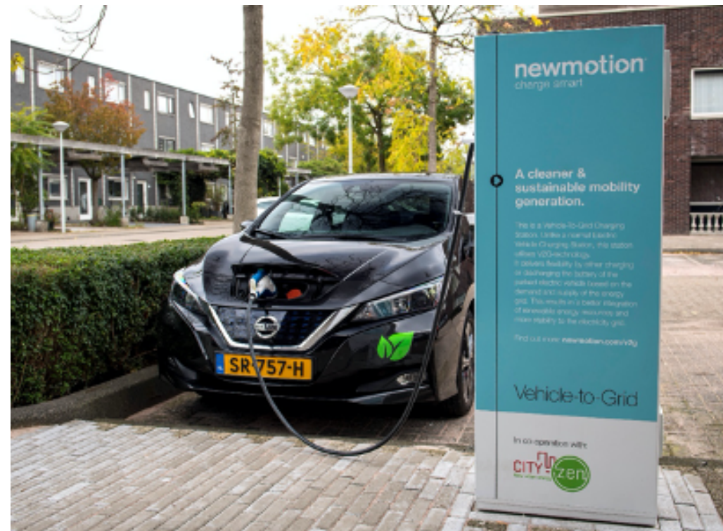
Bidirektionale V2G-Ladestation für den City-zen VPP-Piloten installiert. ©Alliander
