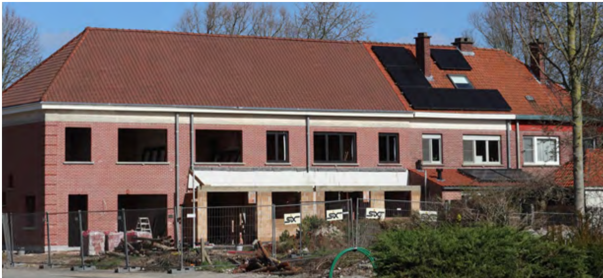
↑ Nachrüstung einer Dämmung in Kortrijk, Belgien. © Agata Smok
