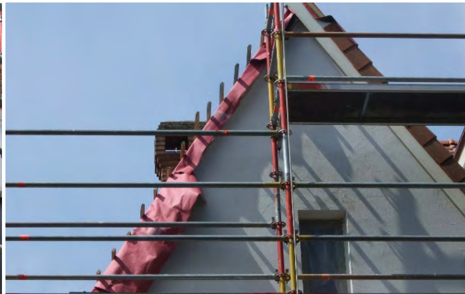
Veranschaulichung der Notwendigkeit Gebäudeknoten neu zu gestalten, z.B. dort, wo nachgerüstetes Dach und Fassade aufeinandertreffen. © Smart Cities Marketplace
