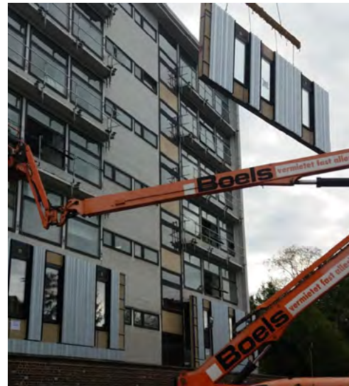
Energieeffiziente Fassadensanierung für CRAC-Bürogebäude in Namur, Belgien © Machiels Building Solutions 2019
