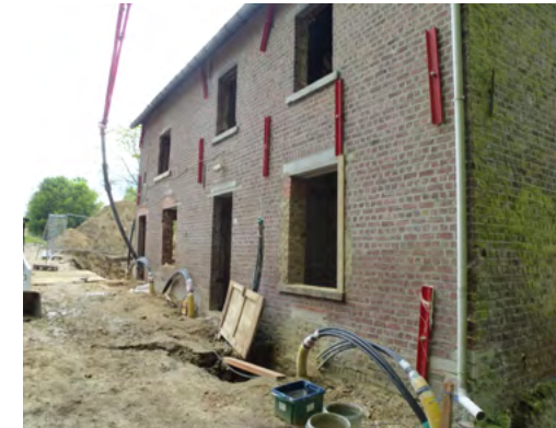
Gebäude vor den Isolierungsarbeiten. © Think E
