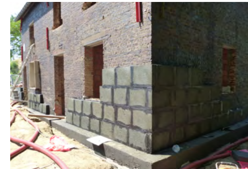
Isolierungsarbeiten. © Think E
