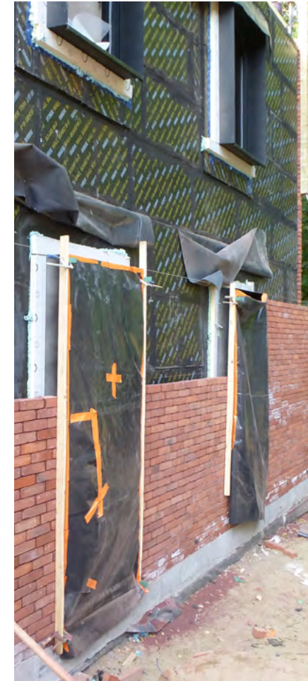
Nachrüstungsarbeiten. © Smart Cities Marketplace
