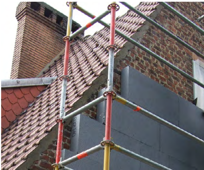
Veranschaulichung der Notwendigkeit Gebäudeknoten neu zu gestalten, z.B. dort, wo nachgerüstetes Dach und Fassade aufeinandertreffen. © Smart Cities Marketplace
