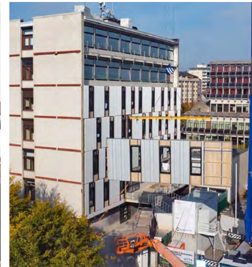
Energieeffiziente Fassadensanierung für CRAC-Bürogebäude in Namur, Belgien © Machiels Building Solutions 2019
