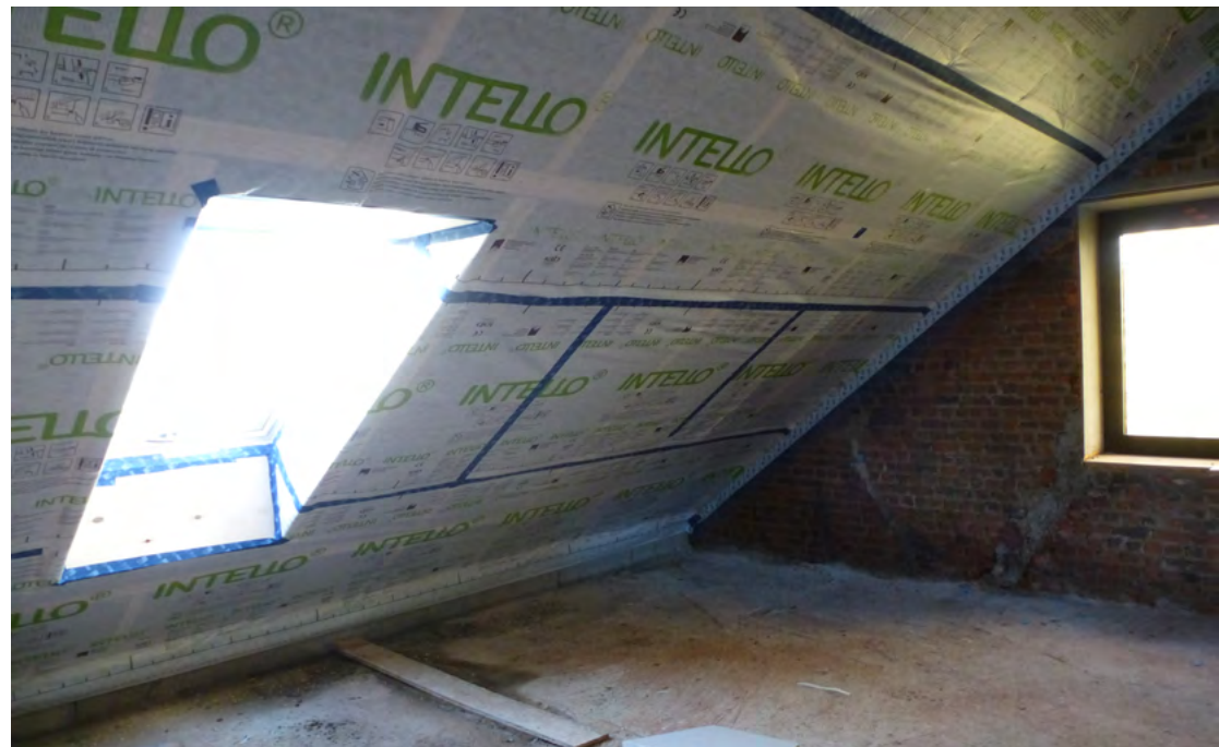
Nachrüstungsarbeiten. © Smart Cities Marketplace
