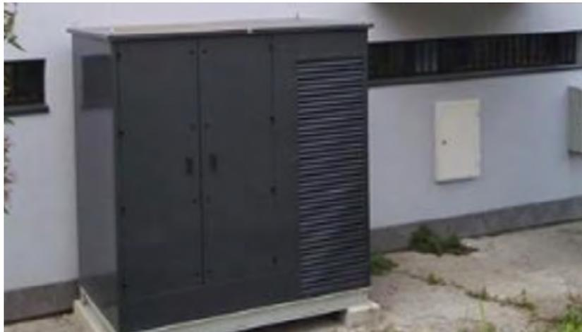
Energiemodul für Mehrfamilienhaus Renovates (D7.1 Fassadenlösungen und Energiemodule). © Renovates
