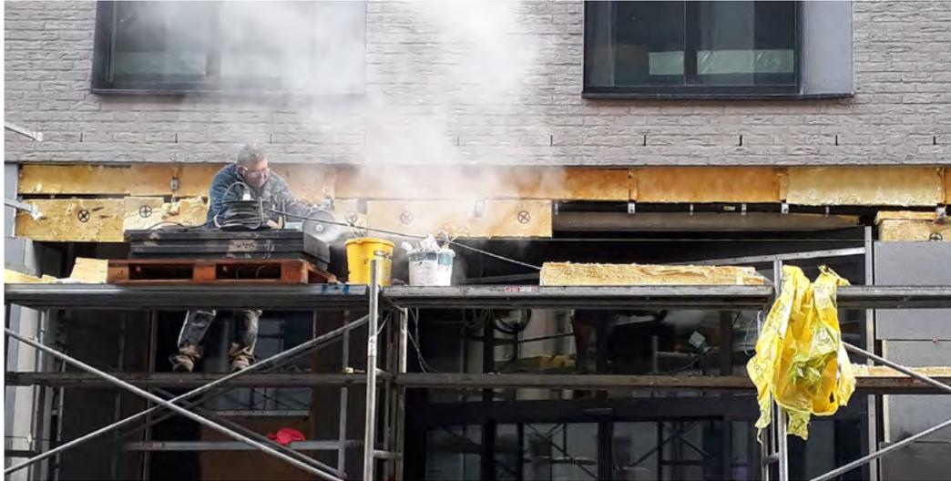
Schlechte Arbeit: Wenn die Dämmplatten nicht gut und dicht miteinander verbunden sind, geht ein Großteil der Dämmleistung verloren. Um solche Situationen zu vermeiden, sind der Aufbau von Kapazitäten bei den Arbeitskräften und eine strenge Kontrolle der Bauarbeiten unerlässlich. © Smart Cities Marketplace
